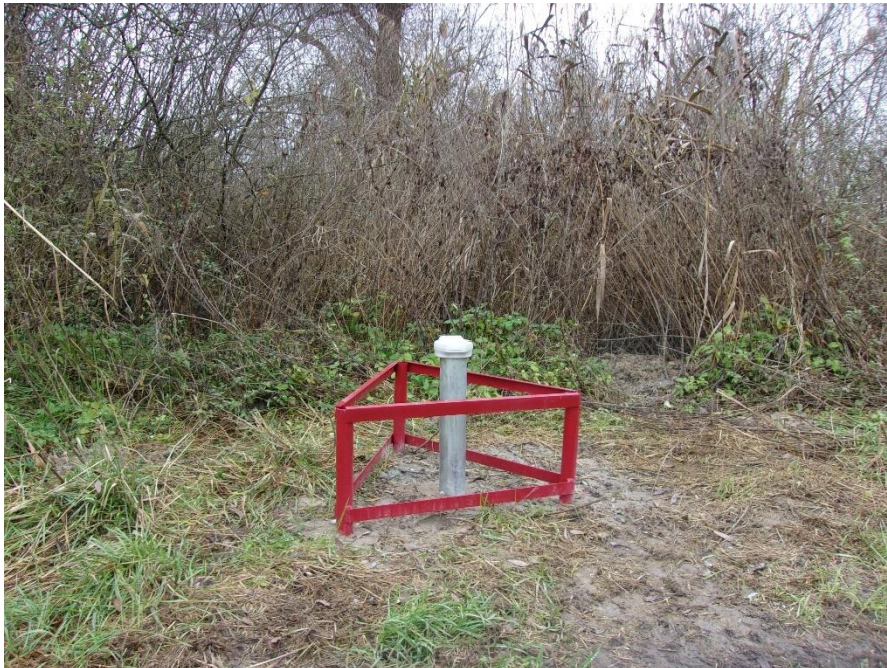
Foto 6: Blickrichtung ~NW; Bereich der Grundwassermessstelle GWM B21
