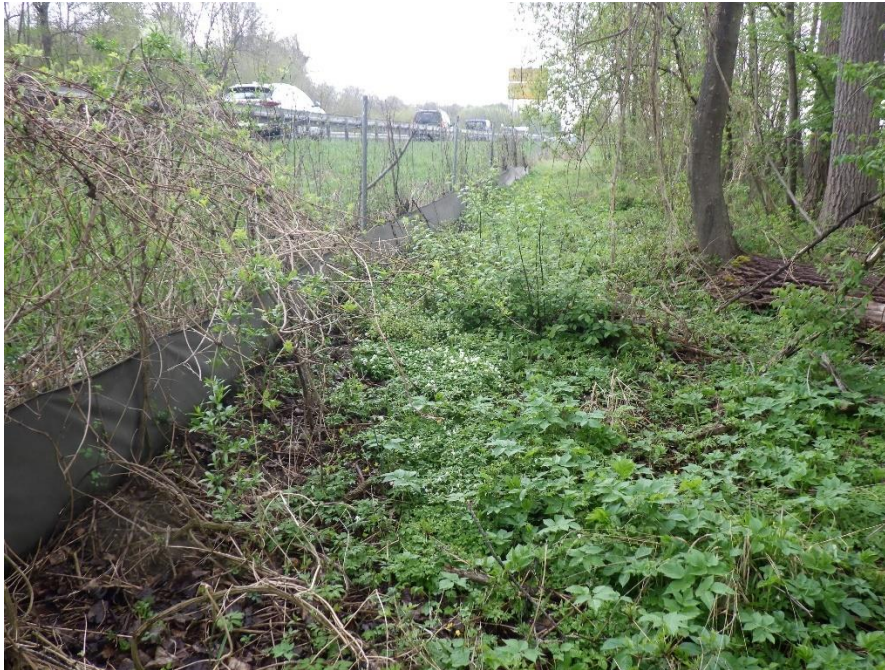
Abb. 11 Nordböschung B 16 westlich Brücke Schornreuter Kanal – Bestand
