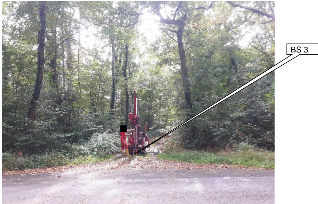
Foto 3: Bohrsondierung BS 3 (Markierung), Blickrichtung ~ S
