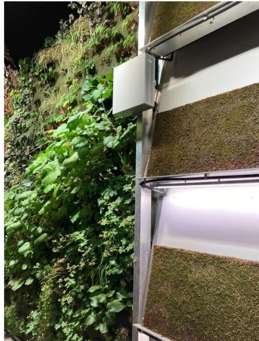
Abb. 03: Aufbau begrünte Wand im Citytunnel Darmstadt/ IoT Messgerät zur Ermittlung der Feinstaub- und Stickoxidkonzentration.
