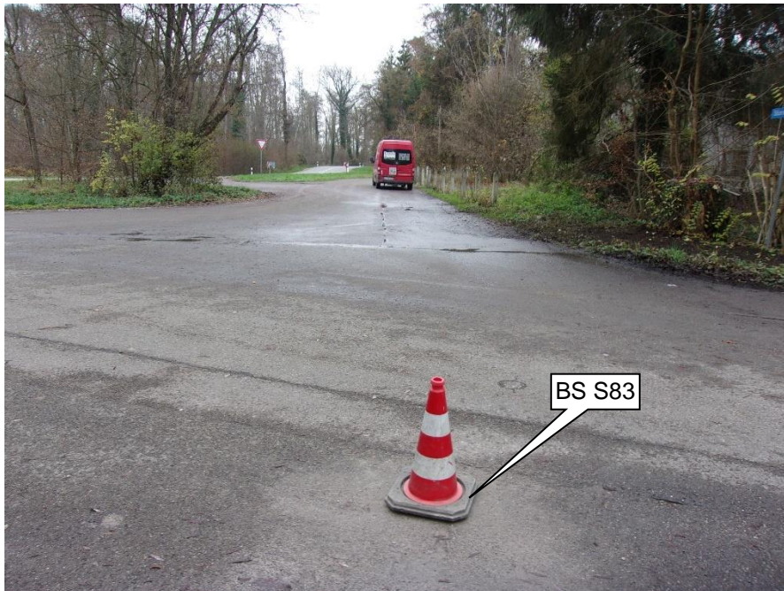
Foto 74: Blickrichtung ~NO; Bereich der BS S83 (Markierung)
