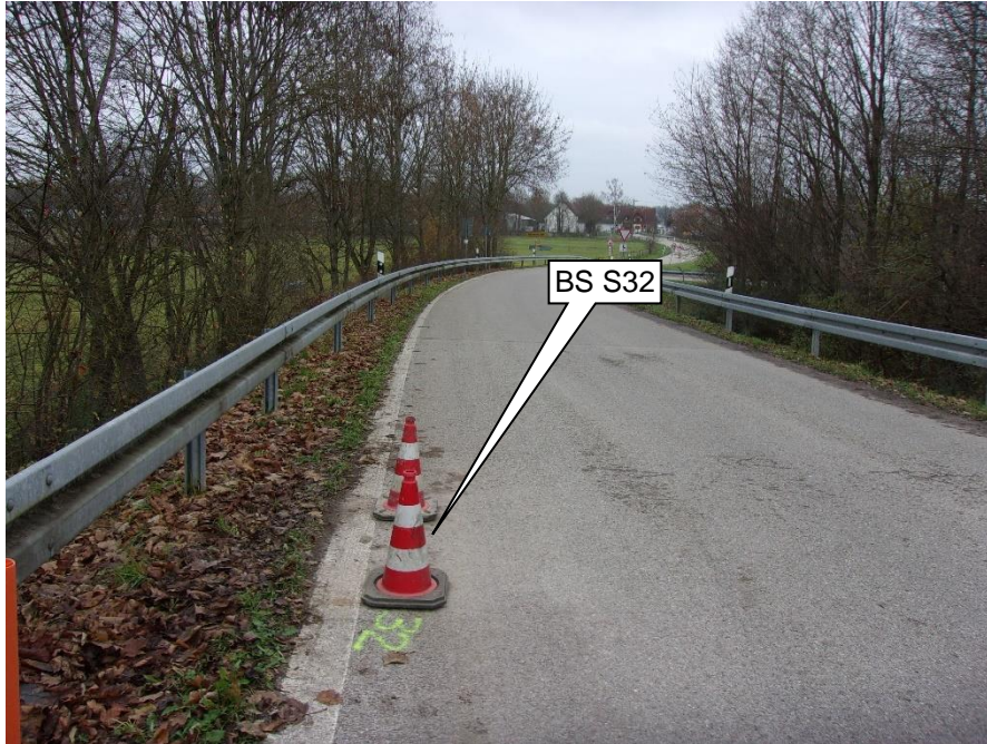
Foto 33: Blickrichtung ~N; Bereich der BS 32 (Markierung)
