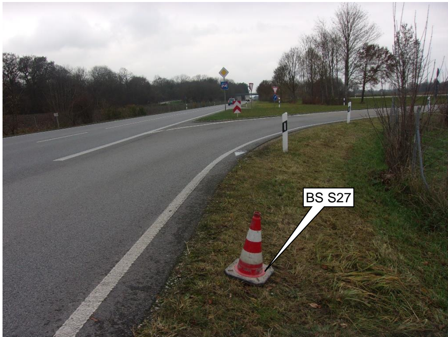
Foto 28: Blickrichtung ~W; Bereich der BS S27 (Markierung)
