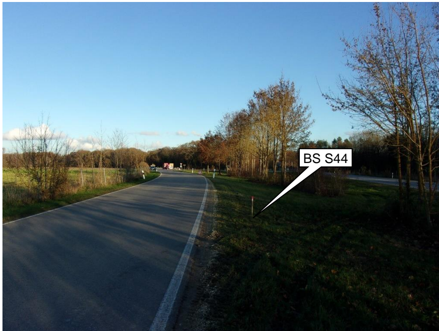
Foto 46: Blickrichtung ~O; Bereich der BS S44 (Markierung)
