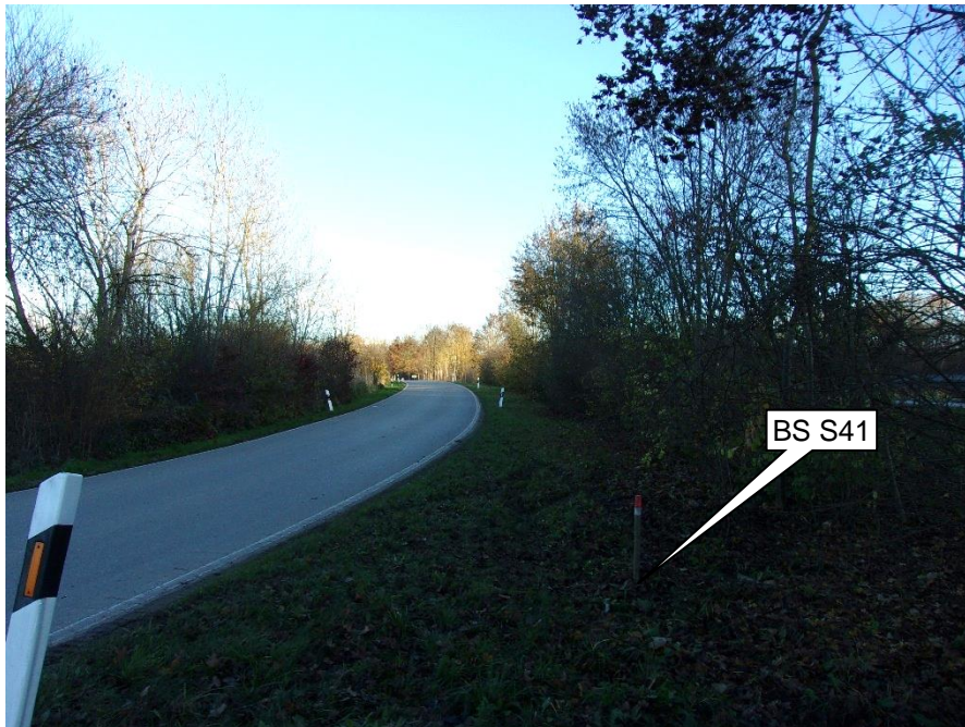
Foto 44: Blickrichtung ~O; Bereich der BS S41 (Markierung)
