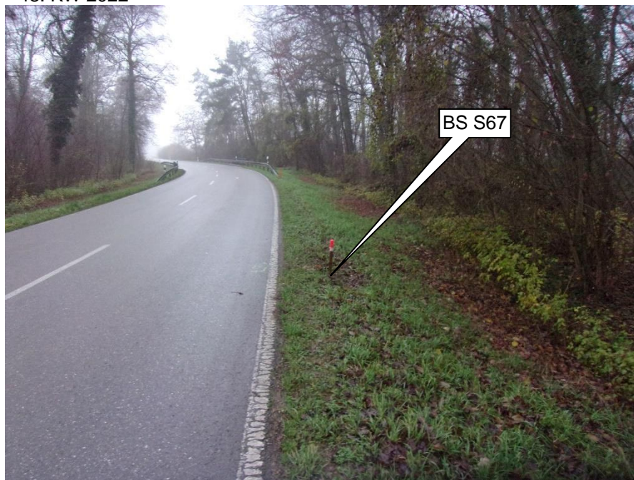
Foto 68: Blickrichtung ~W; Bereich der BS S67 (Markierung)
