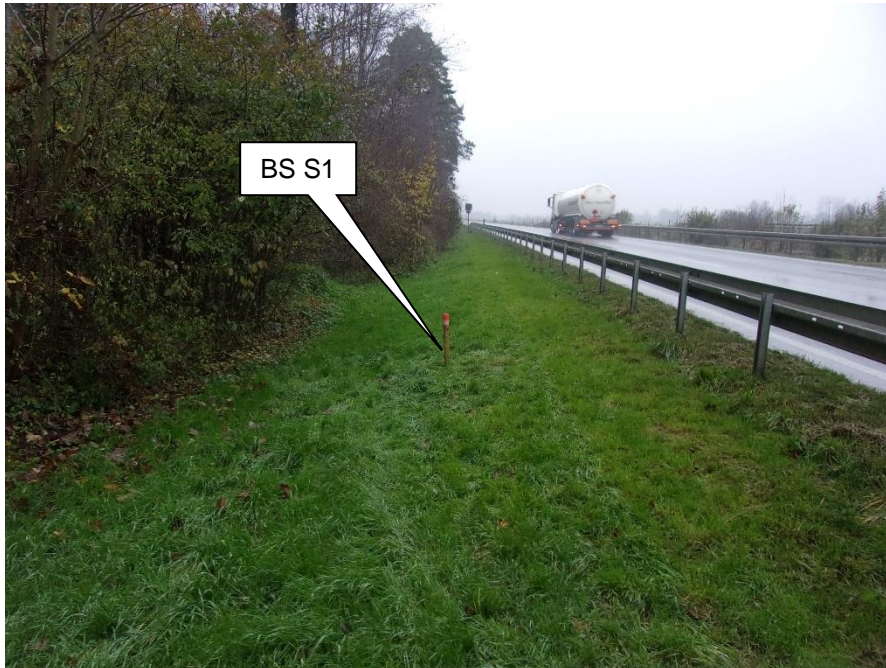
Foto 1: Blickrichtung ~W; Bereich der BS S1 (Markierung)
