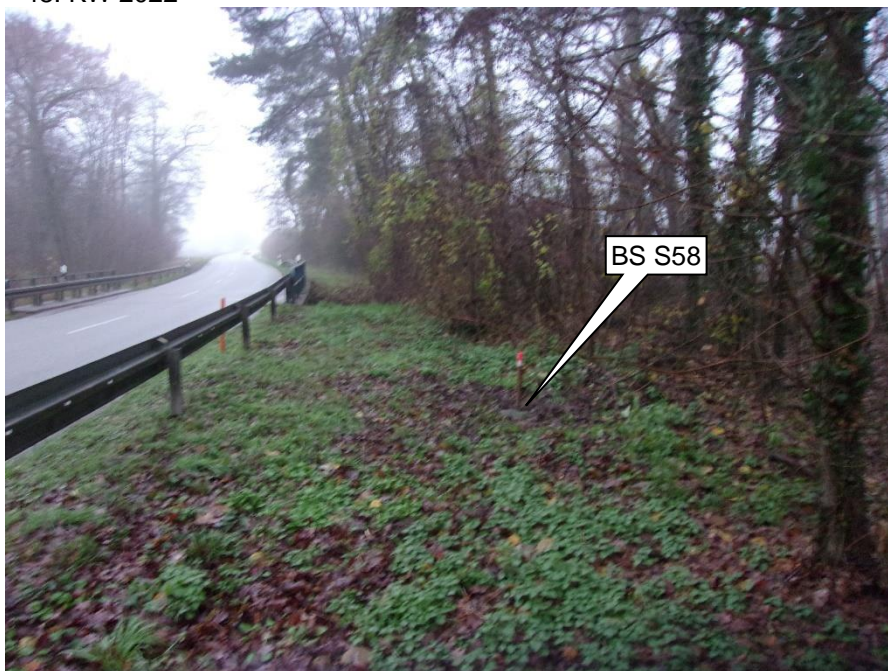
Foto 64: Blickrichtung ~W; Bereich der BS S58 (Markierung)
