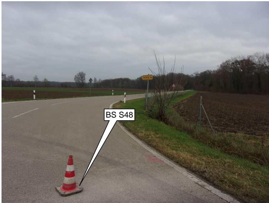
Foto 50: Blickrichtung ~NO; Bereich der BS S48 (Markierung)
