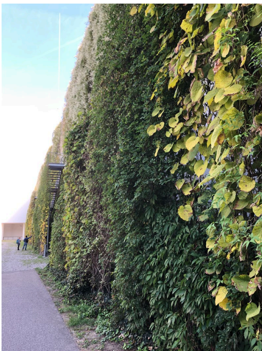
Verschiedene Kletterpflanzen an vertikalen Rankseilen als Kletterhilfe (Basel, CH)
