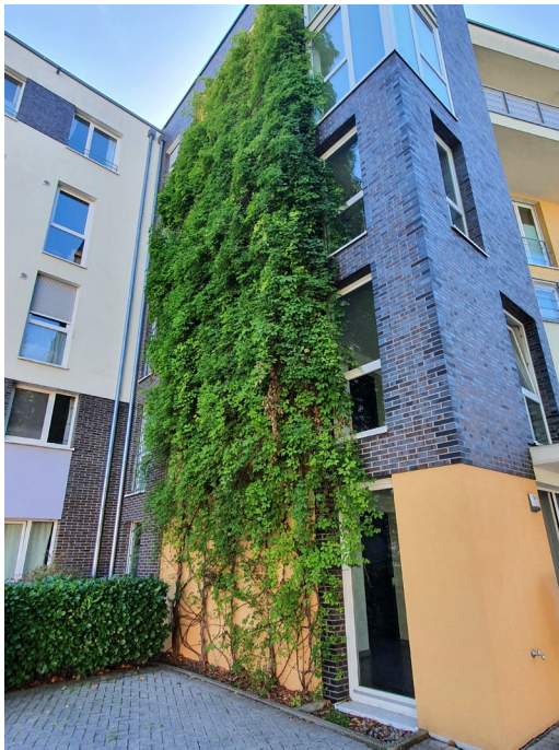
Akebia quinata in ungepflegtem Zustand an vertikalen Rankseilen als Kletterhilfe (Freiburg im Breisgau)
