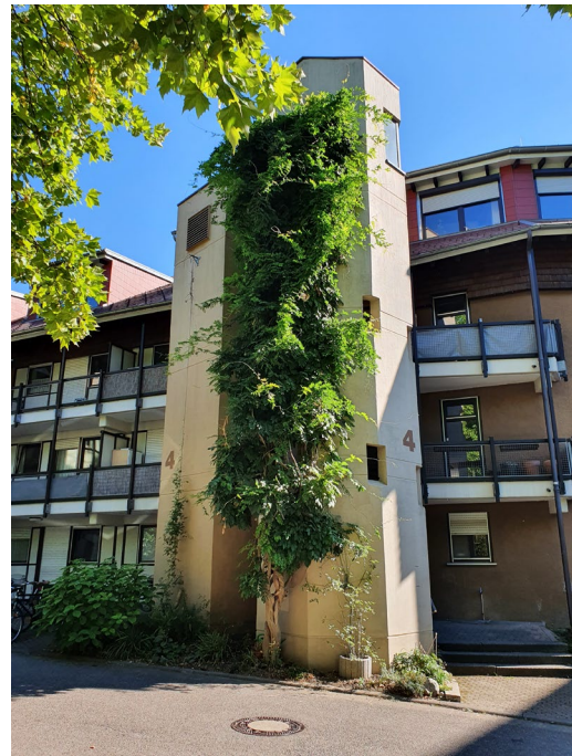
Wisteria (Blauregen) an vertikalen Rankseilen als Kletterhilfe (Freiburg im Breisgau)
