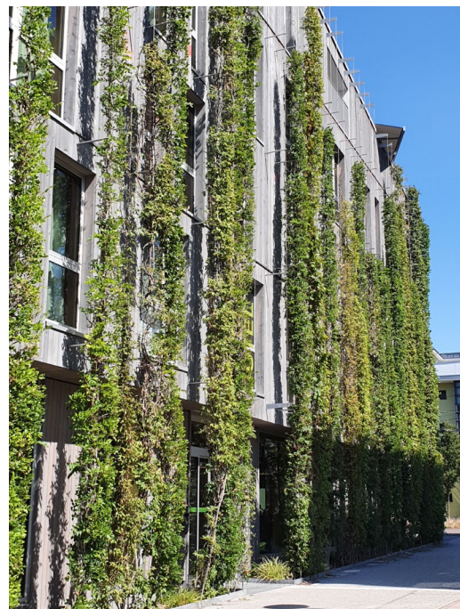
Verschiedene Kletterpflanzen in frisch gepflegtem Zustand an vertikalen Rankseilen als Kletterhilfe
